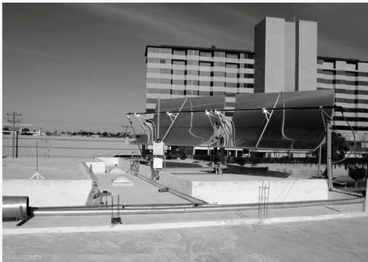
Fig. 3. Colector Solar de Canal Parabólico ubicado en una lavandería de Torreón, Coah., desarrollado por el IIE y en el que participaron profesores y alumnos de ingeniería mecánica del I. T. L. en 2003 – 2004.
